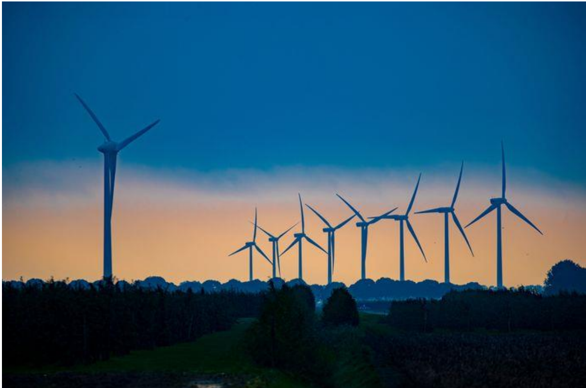
Windturbines van ruim 200 meter hoogte in Flevoland. © Foto Freddy Schinkel
